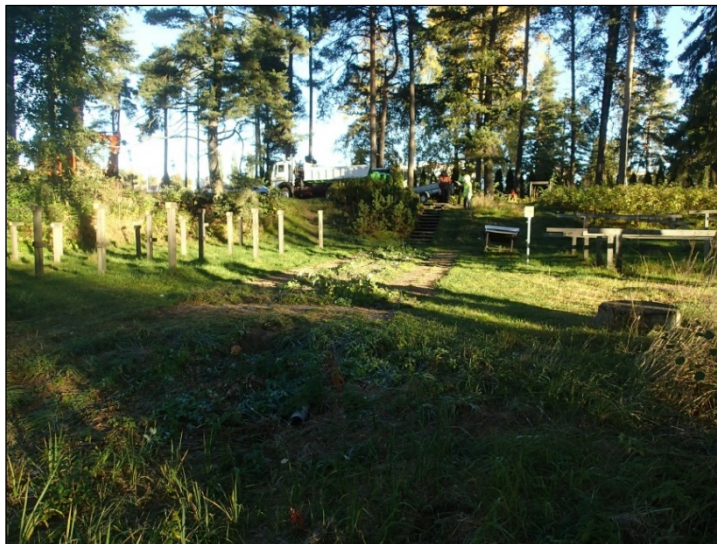
Matonpesupaikka ennen purkutöiden aloittamista. Kuvan keskellä laattakiveys, vasemmalla ja oikealla kuivaustelineiden tolppia. Pohjoiseen.
