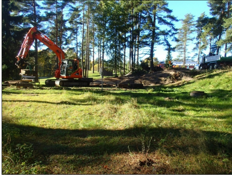
Yleiskuva matonpesupaikasta rakenteiden poistamisen ja alueen länsiosan maisemoinnin jälkeen. Länteen.
