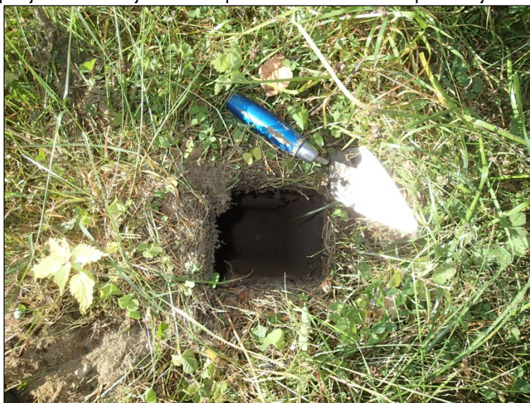
Matonkuivaustelineiden pystytolpan poistoreikä.
