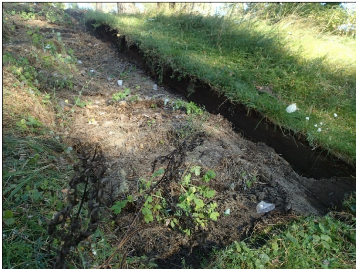
Matonpesupaikan pohjoislaidalla sijainneiden portaiden kohta niiden poiston jälkeen. Pohjoiskoilliseen.
